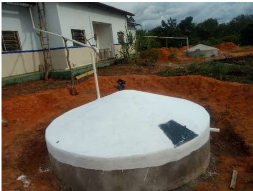
Figura 4. Cisternas construídas pelos quilombolas do Grotão com o apoio da Caritas.
